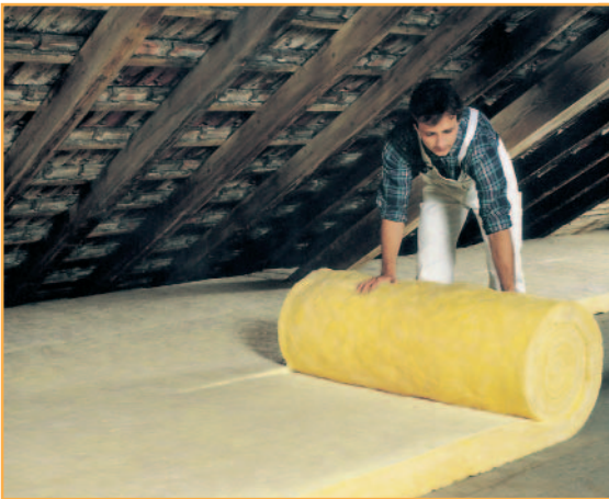
Dämmung oberste Geschossdecke
