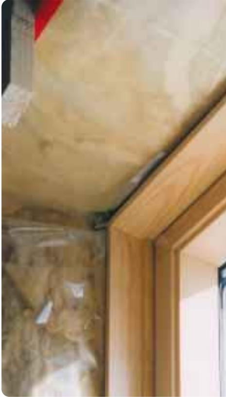
Luftdichter Anschluss eines Dachfensters mit Hilfe einer zugehörigen Schürze
