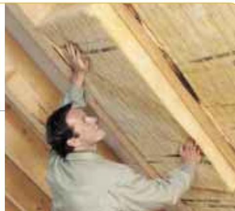
Wärme steigt bekanntlich nach oben. Deshalb sparen gut abgedichtete und gedämmte Dächer eine Menge teurer Heizenergie. Geeignete Anlässe zur Dachdämmung sind ein geplanter Dachausbau oder eine Erneuerung der Dacheindeckung.
