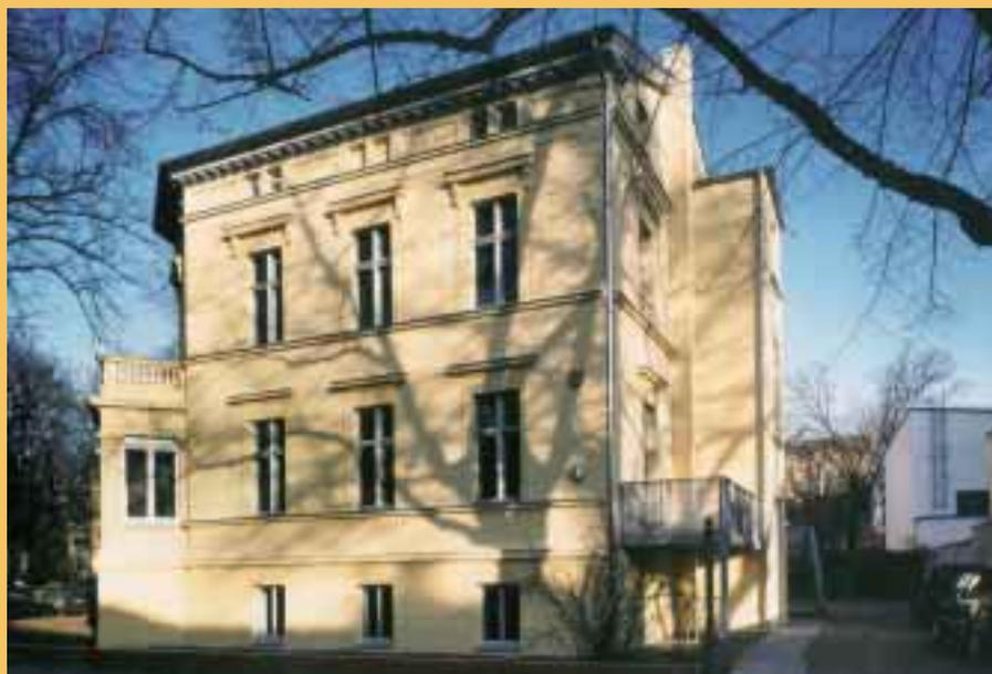
**Hebbelstraße 15** – Das historische Wohngebäude in Potsdam wurde 1999 durch SEHW Architekten Berlin umfassend modernisiert und neben Anpassung der Grundrisse die gesamte Gebäudetechnik ressourcenschonend erneuert. Der Wärmedämmputz der Fassade und die Aufarbeitung der Kastenfenster mit Dichtungen erfolgten in Abstimmung mit der Denkmalpflege. Hofseitige Verglasungen nach Süden gewährleisten passiven Energiegewinn, ein gasbetriebener Brennwert-Kessel sorgt für Warmwasser und Heizung.
