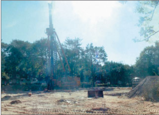
Baustelle im September 2002
