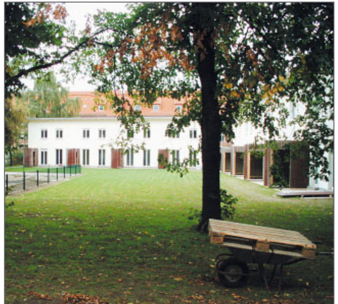
Innenhof im September 2003
