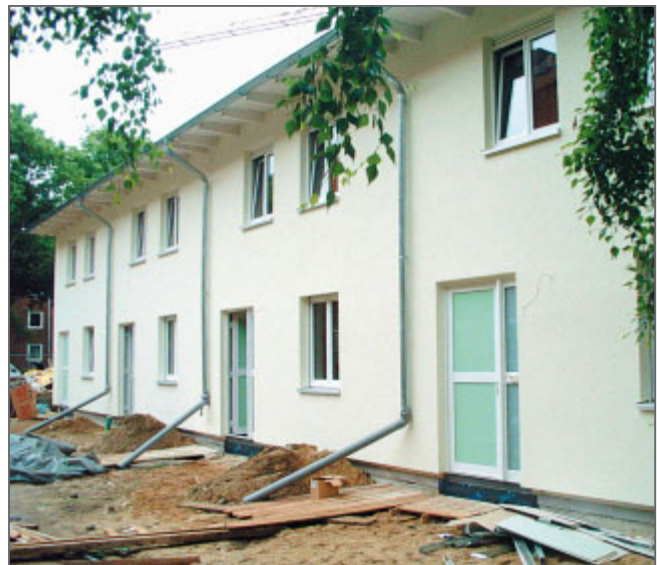
Rohbau im Mai 2003
