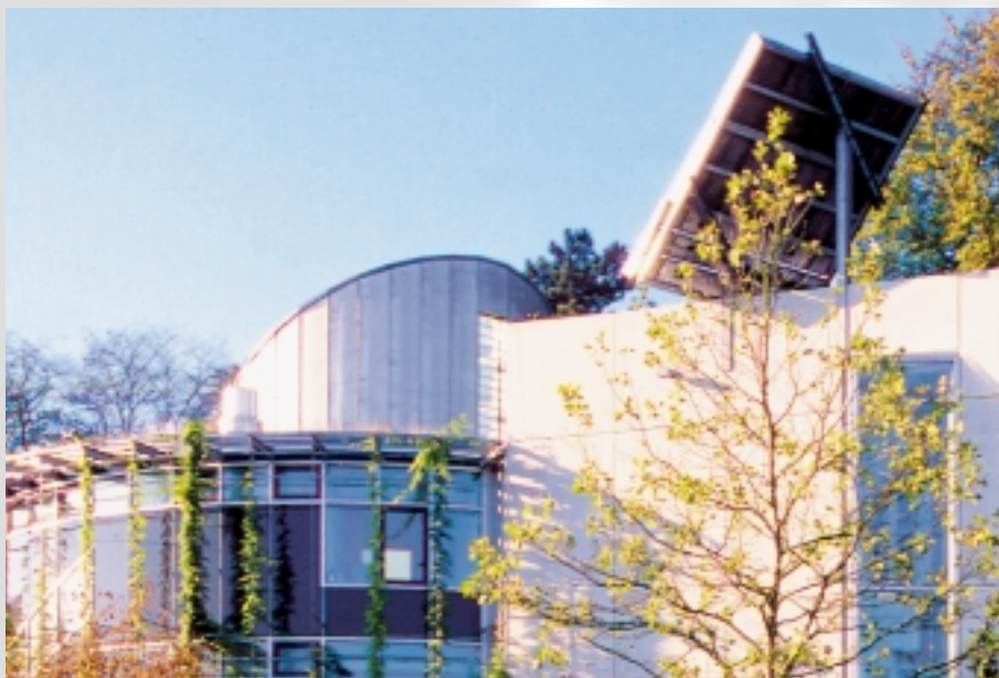
Verwaltungsgebäude der Deutschen Bundesstiftung Umwelt, Osnabrück – hier ist die PV-Anlage nicht in den Baukörper integriert (Architekt: Prof. Erich Schneider-Wessling, Köln)
